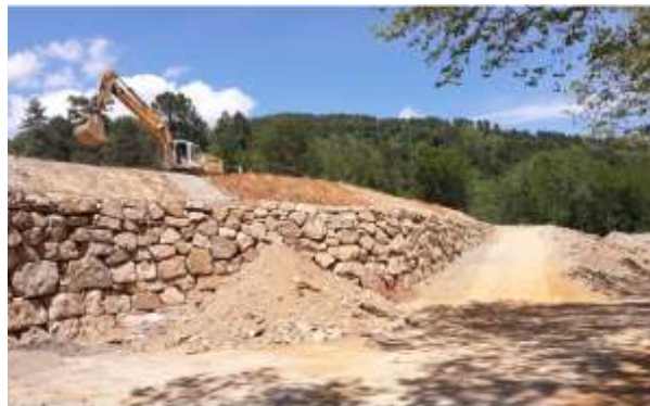
Chantier en cours sur la zone de Saint-Julien-des-Points
