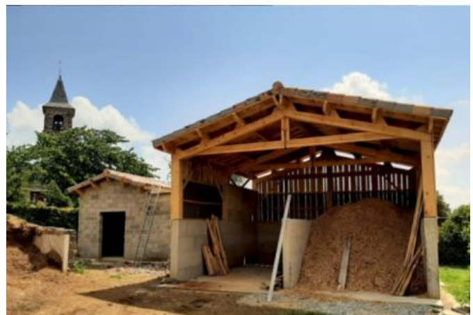
Le silo et le local de la chaudière de Sénéchas. Photographie du bulletin municipal de Sénéchas.
