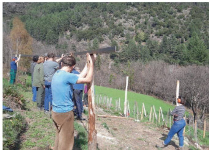
Chantier treille en métal et acacia
